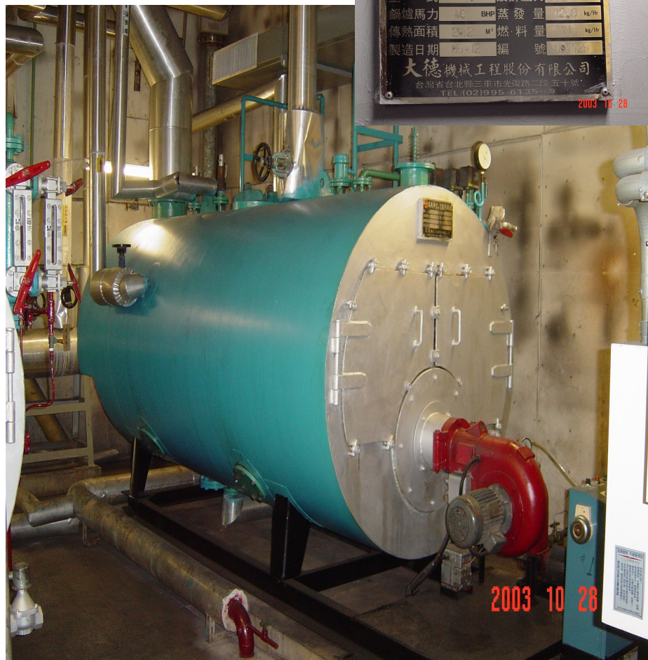
煙管式蒸氣鍋爐
