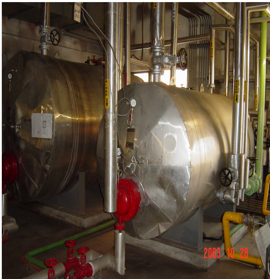
(一壓)臥式蒸氣加熱式水箱
