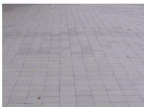
■ 製作堆肥的場地，宜鋪設透水磚，下鋪沙層或排水管。
