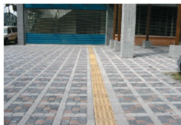
圖2-38 導盲磚的設置
