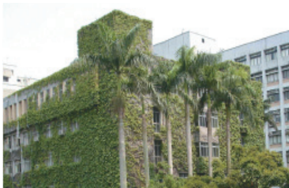
圖2-53 校園建築立面可運用植栽與開口部綠化方式遮蔽太陽輻射熱以降低外殼受熱。
