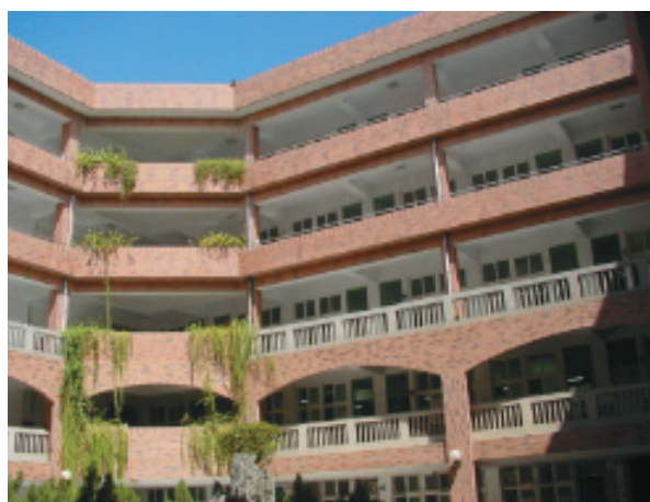
圖2-52 教室走廊與陽台的設計可兼具遮陽、導風及避雨的功能。
