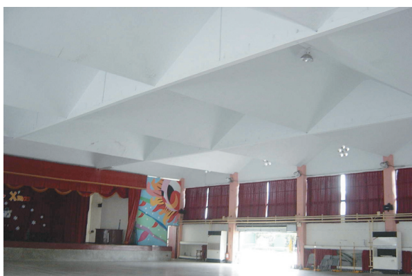
圖2-57 室外光線進入室內後與壁面的設計有關，包含材料反射率等因素，天花板形狀應能以光反射進入室內空間內部為主要考量，以獲得較佳的視覺均齊度。
