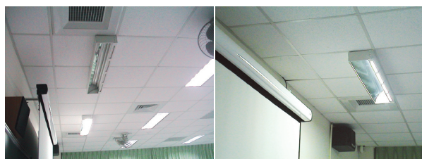
圖5-1 (a) (b) 40W×2之T-5省電燈管及分區分段開關控制
